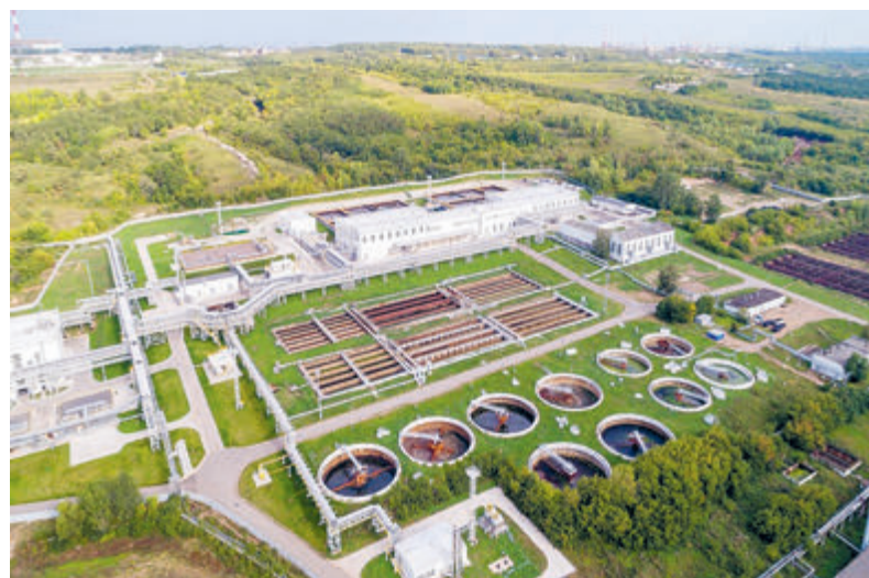
Комплекс биологических очистных сооружений «Башнефти» является одним из крупнейших в Евразии.
